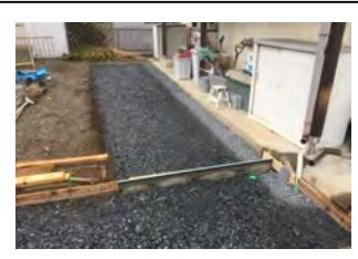
足元の照度も確保する必要があるので、庭園灯を配置して自動点灯するようにしました。冬季のコンクリート工事は完全に固まるまで、夏の倍の日数がかかります。また敷設直後の雨や凍結に気を使いながらの施工となります。
